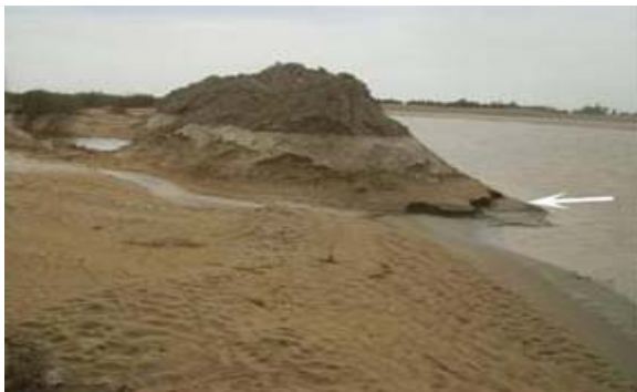
شکل (۱۱): فرسایش توده ای خاکریزهای (گوره ها) ساحل رودخانه سیستان (حافظی مقدس، ۱۳۹۱).
