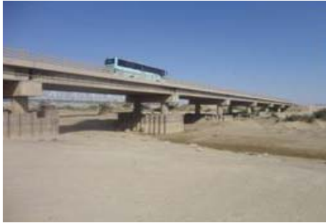
شکل (۱۰): اثر پل نهراب بر مورفولوژی و رسوبگذاری رودخانه سیستان، الف) تصویر ماهواره ای از پل نهراب و اثرات ریختاری آن بر رودخانه (فرسایش در بالادست و رسوب گذاری در پایین دست)، ب) محافظت پایه های پل نهراب با صفحات فلزی
